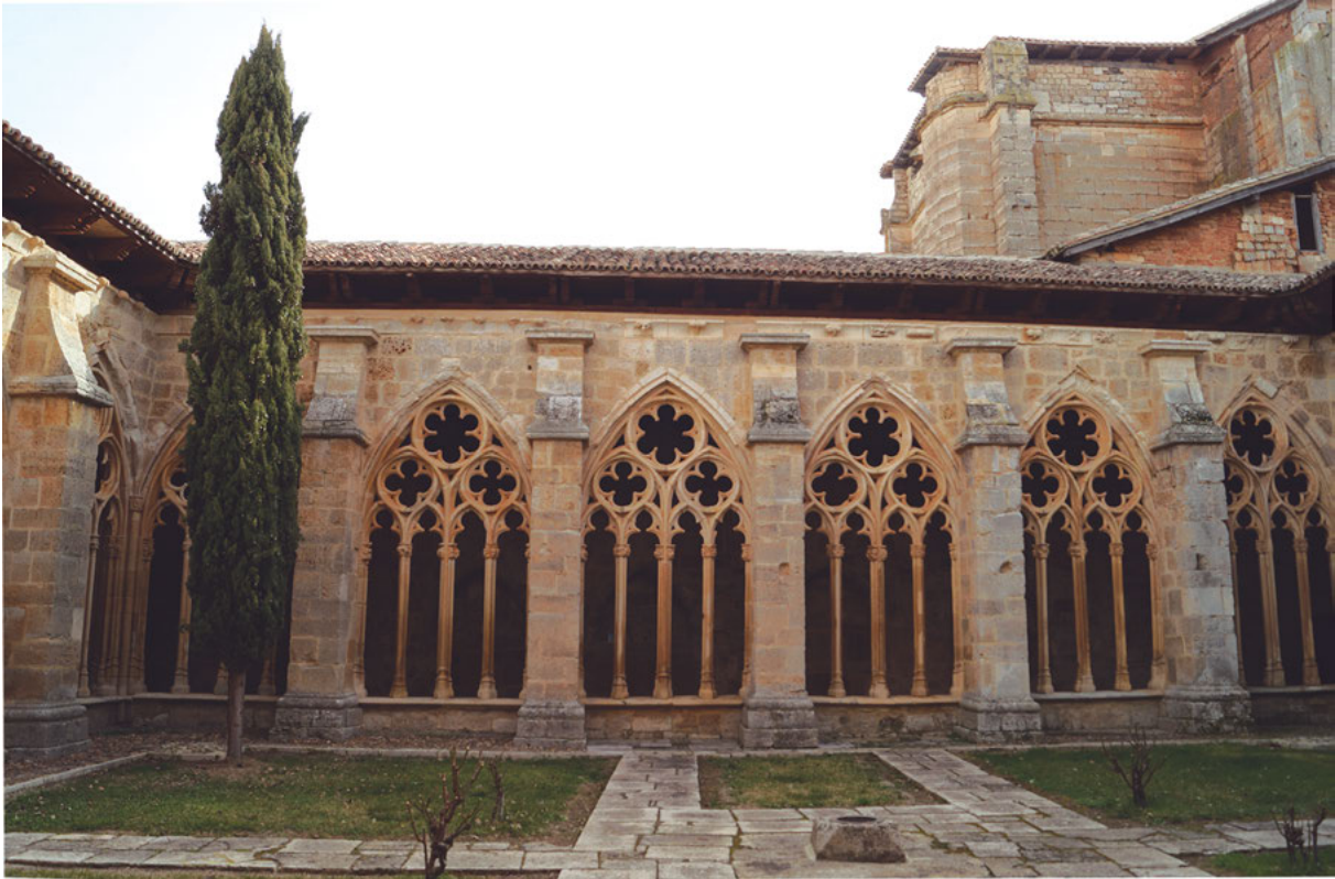
Fig. 6: Tracerías exteriores de un de los laterales del claustro. Foto de autor
