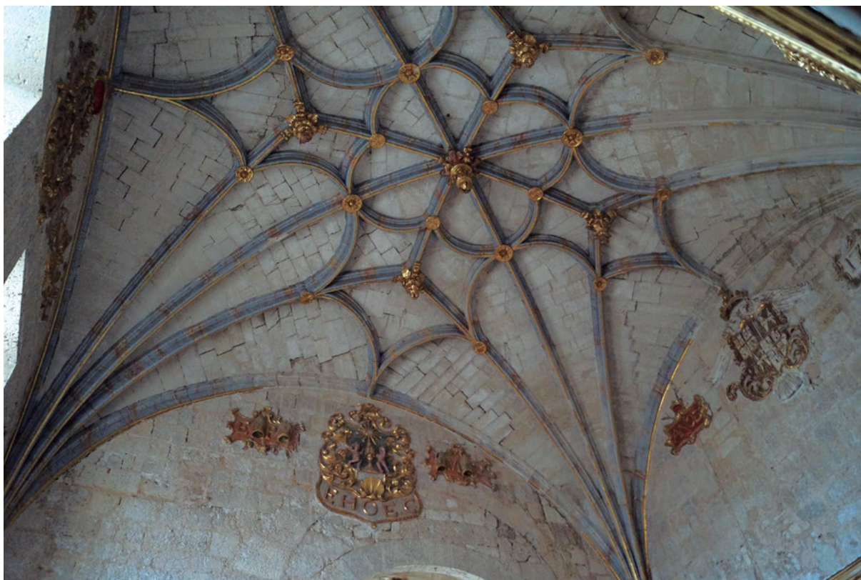
Fig. 7: Bóveda de crucería de la sacristía, con el escudo conmemorativo de la sede Episcopal de Sasamón y el escudo de Carlos V. Foto de autor
