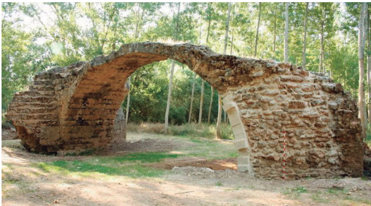
Fig. 4. Arco n.º 5 del puente de Royales en proceso de consolidación durante la campaña de 2021
